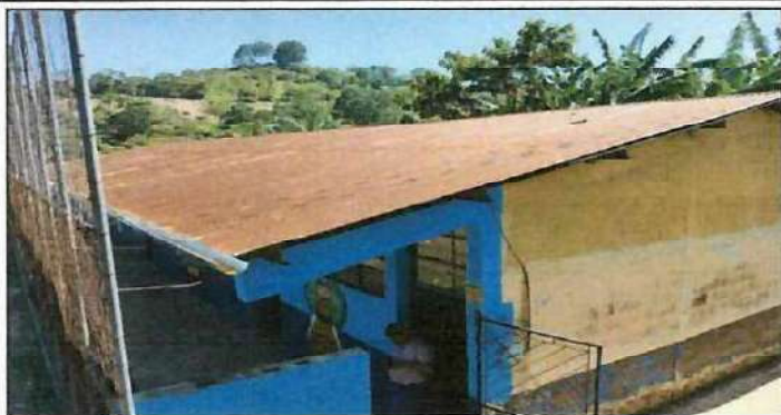
Foto1: Sustrucion de lamina en mal estado de aulas por lamina troquelada aulas
