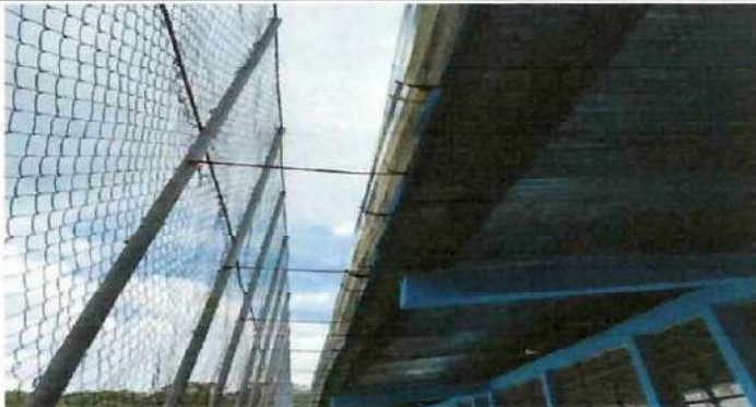
Foto 2: Sustrucion de canales existentes de la Direccion, aula I,II y III
