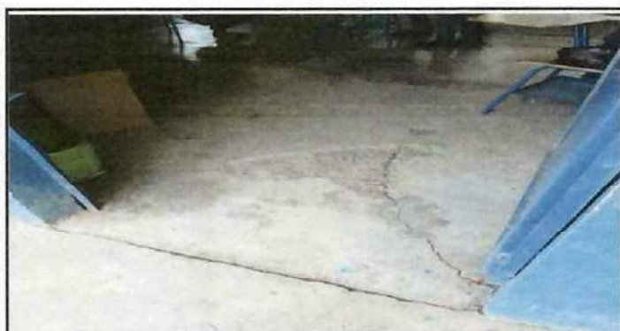
Foto 3: Sustrucion de piso de cemento en mal estado por piso ceramico
