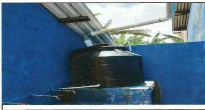
Foto 6: Sustrucion de tinaco pequeño con un grande de 2500litros de capacidad.
